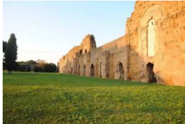
Abb. 4: Rom, Centro dello Sport der Banca d'Italia. Abschnitt der Aqua Marcia und der Aqua Claudia sowie der frühneuzeitlichen Acqua Felice
